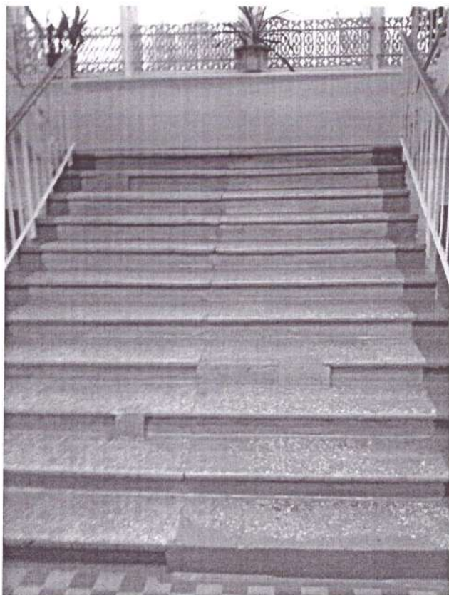
Лестница с 1 этажа на 3 этаж (основная школа)
